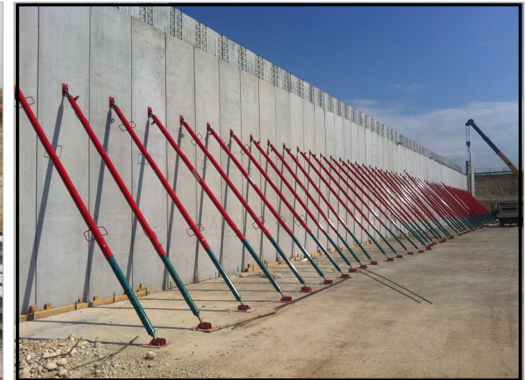
PUNTELLAMENTO PROV. BILASTRE
